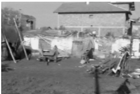
写真23 破壊された家
