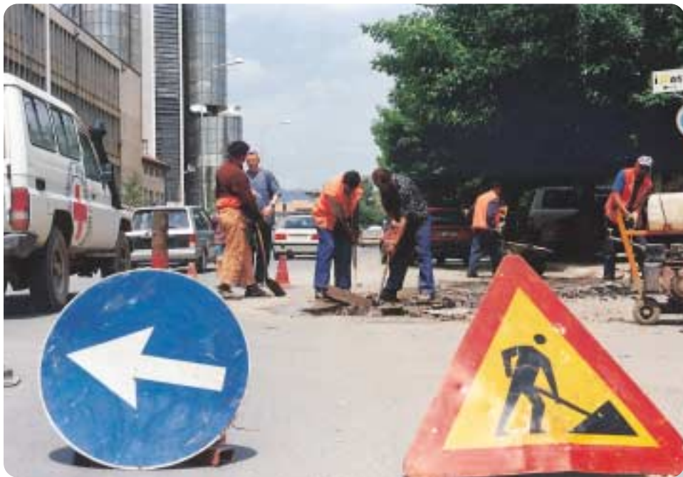
道路の補修も進んでいる（プリスティナ）
