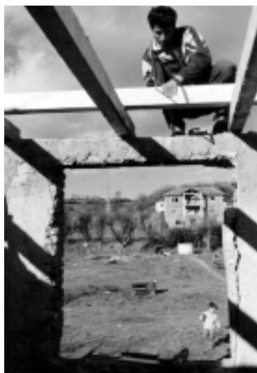
コンボでは今も、家の修復作業が進められている
