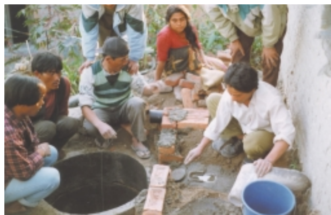
貧困層住宅地の下水管敷設をするカンボジアの人々 (写真提供：UNCHS)
