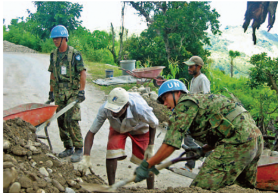
東ティモールでのPKOに参加する自衛隊員たち。山間部で道路修繕工事を行っている=2004年
