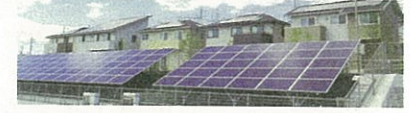
物流拠点施設にも、太陽光発電やLED照明など、創エネ・省エネを導入。写真は「DPL横浜大黒」(上)。太陽光発電所を設置して省エネや住民の暮らしに役立ってるまちづくり事業も展開。
